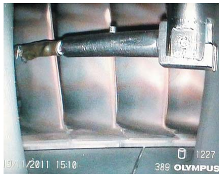
Рис. 2. Наблюдение за работой датчика и визуальный контроль поверхности лопаток ТВД
