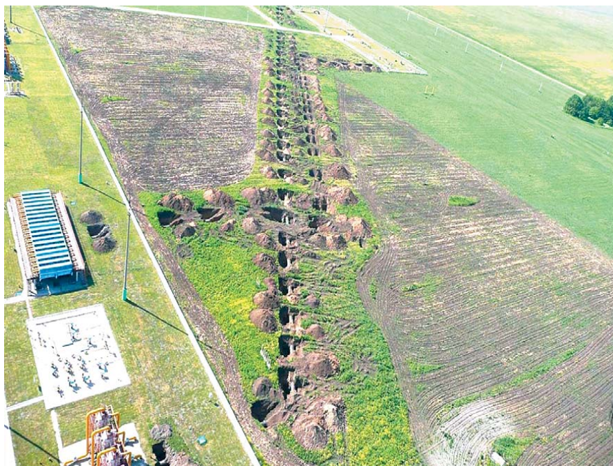
Рис. 1. Диагностические обследования в шурфах трубопроводов-шлейфов КС
