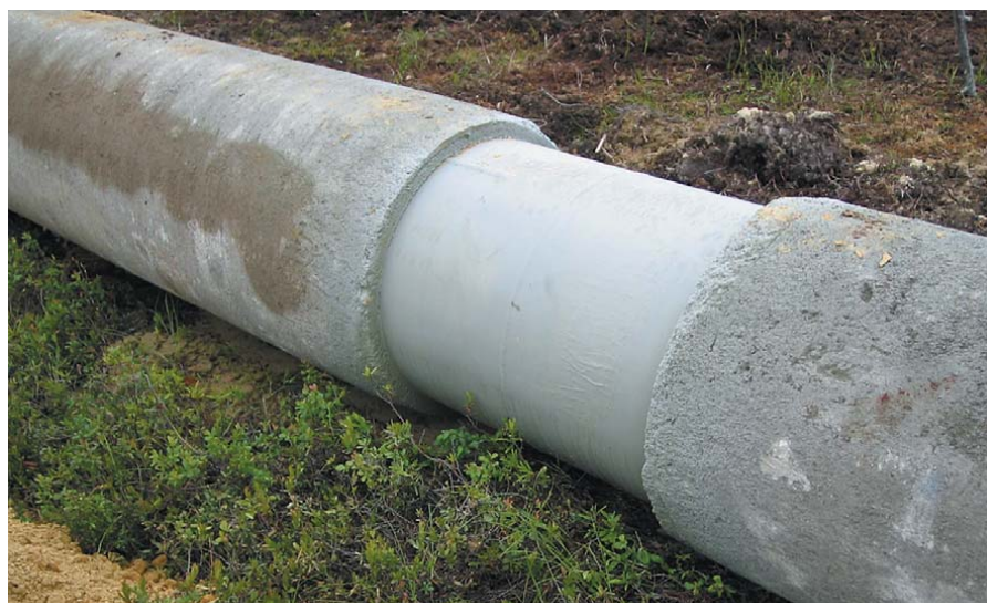
Рис. 1. Применение обетонированных труб на подводном переходе через р. Вал
